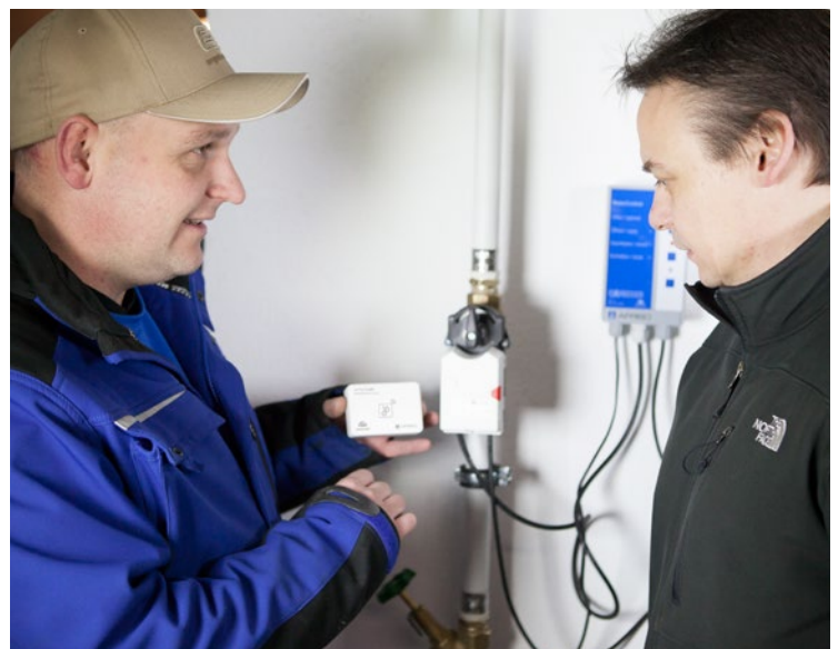
Das Absperrventil WaterControl 01 schließt im Alarmfall nachfolgende Leitungen von der Wasserzufuhr ab.
